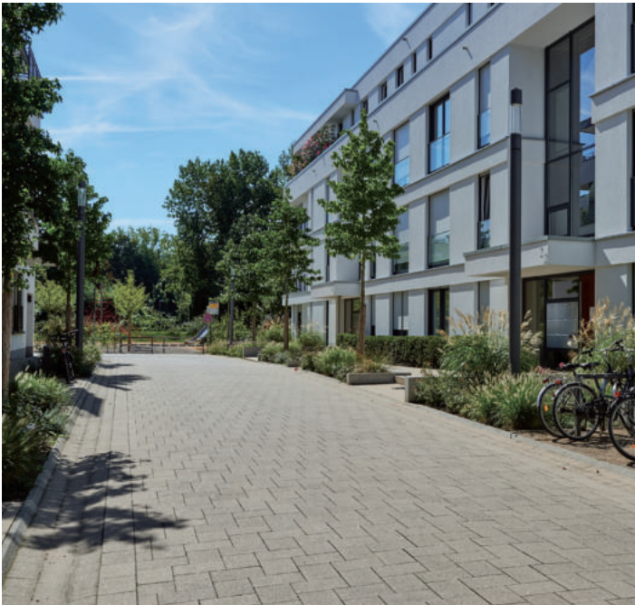
PIANEZZA Pflaster, Stufen und Conca Rinne in Projektfarbe; Köln
